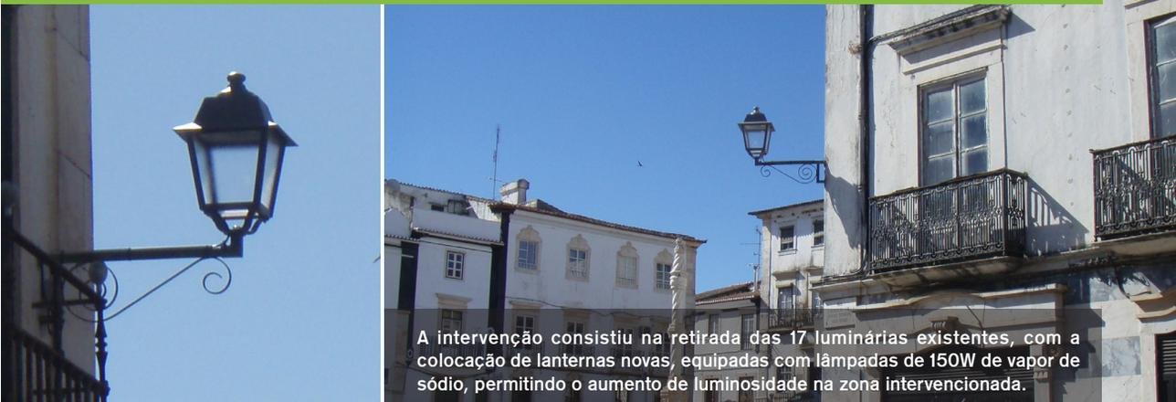
A intervenção consistiu na retirada das 17 luminárias existentes, com a colocação de lanternas novas, equipadas com lâmpadas de 150W de vapor de sódio, permitindo o aumento de luminosidade na zona intervencionada.
