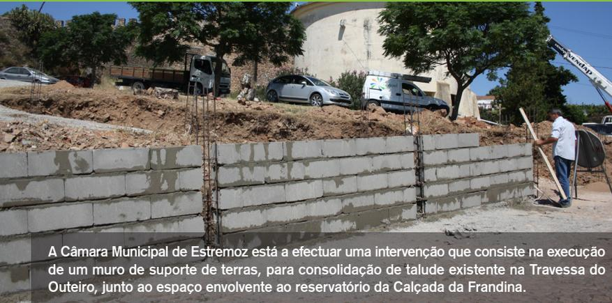
A Câmara Municipal de Estremoz está a efectuar uma intervenção que consiste na execução de um muro de suporte de terras, para consolidação de talude existente na Travessa do Outeiro, junto ao espaço envolvente ao reservatório da Calçada da Frandina.
