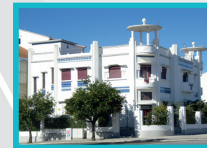
12-Casa Manuel de Sousa Coordenadas: 38°50'42.88"N 7°35'1.01"W
