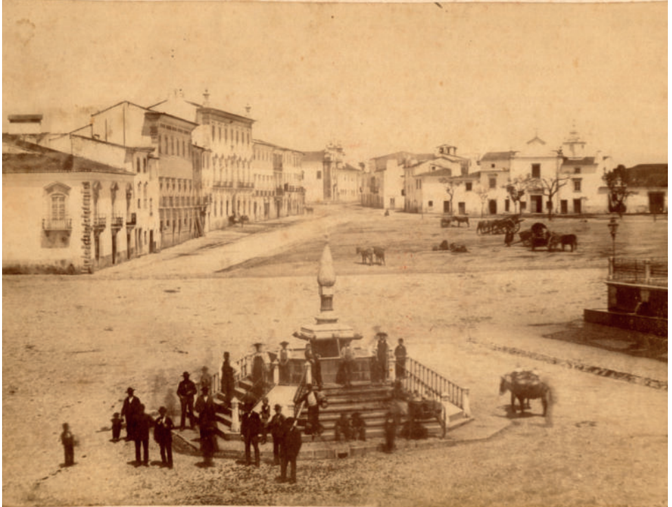
Fig. 23 - Fonte das Bicas. Fotografia cedida pela Biblioteca Municipal de Estremoz/Arquivo Fotográfico
